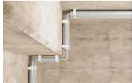
Befestigung von Kunststoff-Isolierrohren
