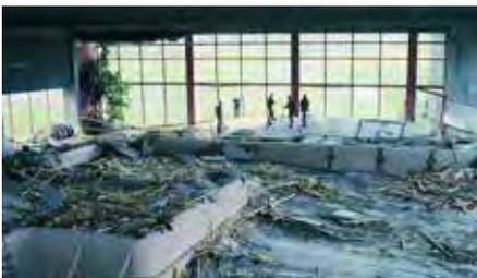
1985 versagte die abgehängte Betondecke eines Hallenbades im schweizerischen Uster. Die Aufhängungen der Decke aus nichtrostendem Stahl A2 zeigten rein äußerlich keinerlei Mängel, waren jedoch im Innern teilweise vollkommen durch Spannungsrisskorrosion zerstört.
