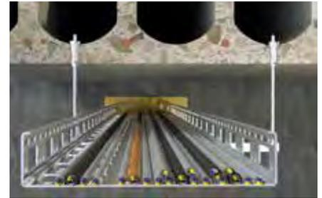
Kabeltragsysteme in Spannbeton-Hohldecken
