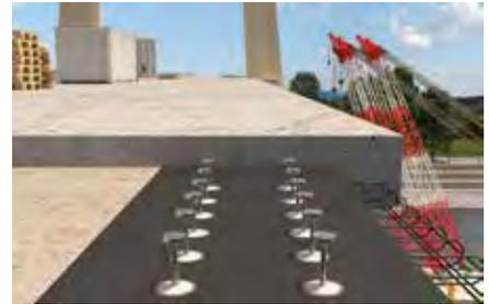
Brückenkappenanker mit Kopfplatte
