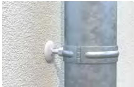
Befestigung eines Regenfallrohrs mit dem FID-R
