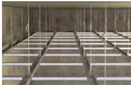
Abgehängte Decke mit Noniushänger
