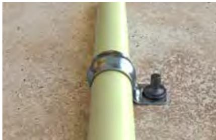
Befestigung von Panzerrohren
