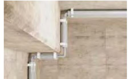
Befestigung von Kunststoff-Isolierrohren
