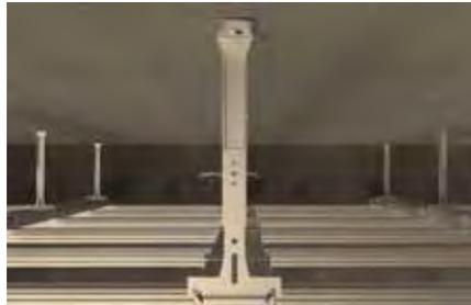
Abgehängte Decke mit Noniushänger
